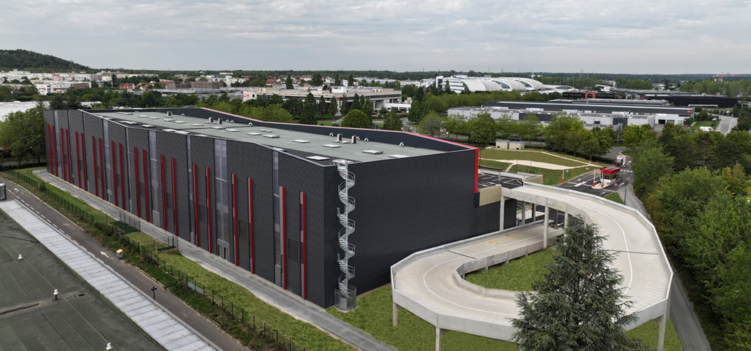
MEHRSTÖCKIGES LAGER Elancourt (Paris) SEGRO
